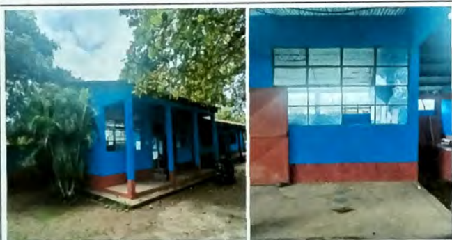
Foto 3: MODULO A Vista frontal Ventanería se retiraran los vidrios y se modificara el recuadro colocando 3 hembras verticales y 3 hembras horizontales. Se pintara el estructura de ventana
