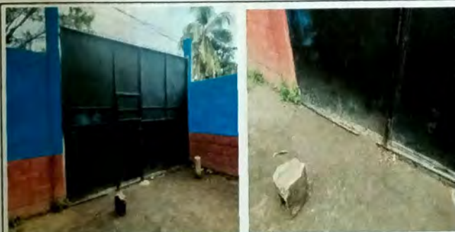
Foto 11: Porton de acceso, corregira la parte inferior picada y se instalara chapa nueva, se corregiran pasadores quebrados
