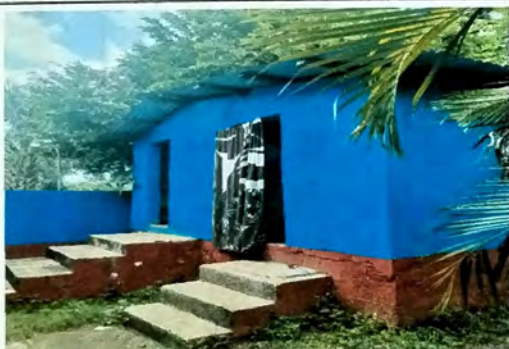
Foto 7: MODULO C Vista de servicios sanitarios, se ampliara modulo de gradas-
