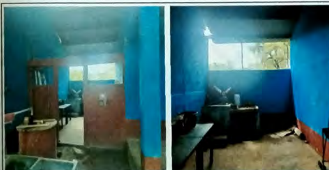
Foto 5: MODULO B Cocina Se hara base de concreto con azulejo. Se cambiara la plancha de cocina regional. Se instalara piso ceramico antideslizante. Se retocara estufa regional. Se instalara luminaria
