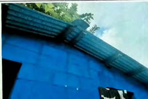
Foto 9: MODULO C SANITARIOS se aperturaran 2 vanos nuevos para puerta y se instalaran 4 puertas nuevas con chapa. Se cambiarian 2 sanitarios y se instalaran 2 nuevos. Se instalara Azulejo en muros
