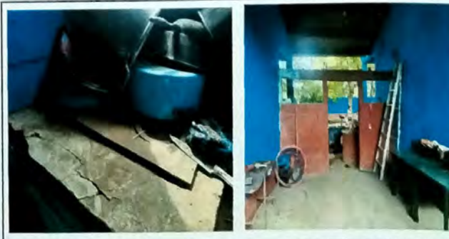
Foto 6: MODULO B Sustitucion de plancha metalica, se dara continuidad al muro e ingreso 1.00 mts arriba. Se suministrara puerta metalica mas chapa.
