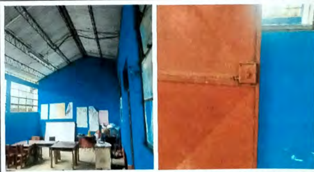
Foto 4: MODULO A se cambiara una par de laminas dobladas y se dara mantenimiento a Joist 10 unidades por 10.0 ml y se dara mantenimiento a puertas de metal y se cambiara chapa.
